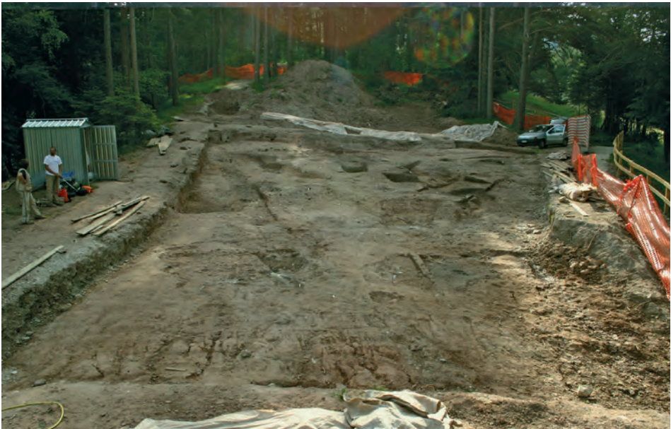
Fig. 3: Panoramica dell'area di scavo (da ovest).
