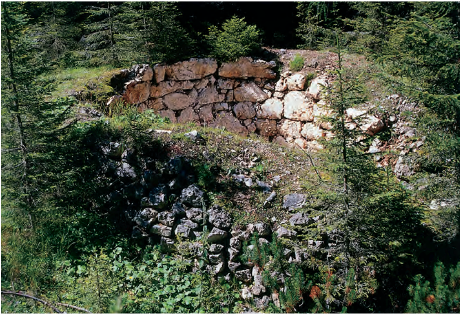
Für diesen aufgelassenen und stark verfallenen Kalkbrennofen am Eingang zum Antersasc-Tal (1750 M.ü.d.M.) boten die ausgedehnten Geröllhalden am Fuße des Gherdenacia-Massives ausreichend Brenngut und die umliegenden Waldbestände genügend Heizmaterial. (Aufnahme vom Verfasser)
