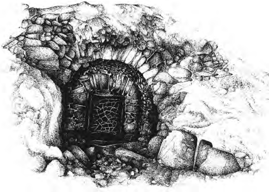
Feuerungsfront eines heute noch gut erhaltenen Kalkbrennofens in der Örtlichkeit Frëina (Eigentümer ist Mattia Clara vulgo Tì dl Longher), nach einer Zeichnung von Roswitha Asche (1989), Berkheim.
