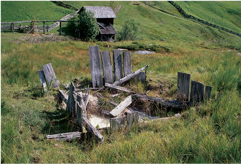
Noch verhältnismäßig gut erhaltene Kalklöschgruben trifft man unweit der Bauernhöfe von Seres in Lungiarül/Campill an. In solche Legen wurde der frischgebrannte Kalk mit Wasser eingelöscht und dann feucht gelagert. Die hier abgebildete Lege gehört zum Hof „La Pera“ in Miscì. (Aufnahme vom Verfasser)
